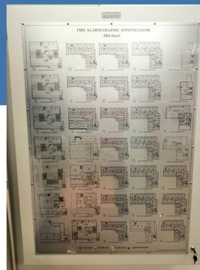
• แผงแสดงจุดแจ้งเตือน (Fire Alarm Panel)
