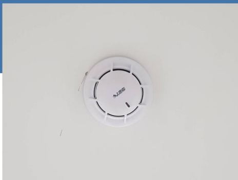
• อุปกรณ์ตัวจับควัน (Smoke Detector)
