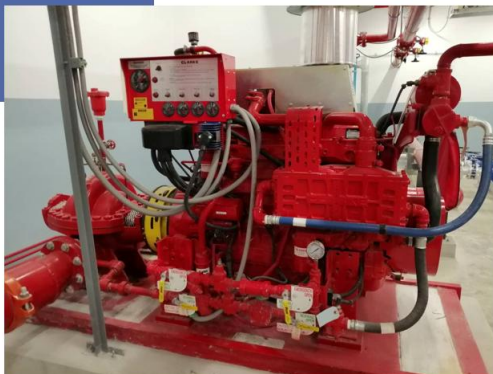
ปั๊มดับเพลิง (Fire Hydrant Pump)
