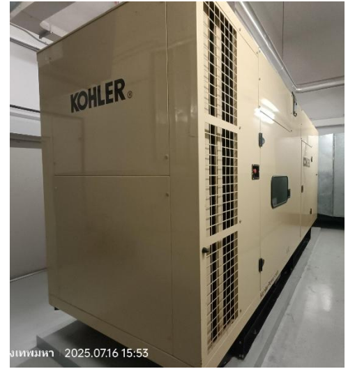
ภาพที่ 2.23 เครื่องกำเนิดไฟฟ้าสำรองฉุกเฉิน (Generator Set)
