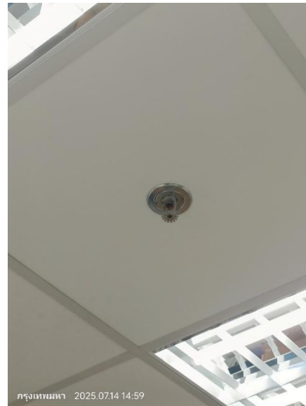
ภาพที่ 2.26 ระบบตรวจจับควัน (Smoke Detector) และระบบดับเพลิงอัตโนมัติ (Sprinkler)
