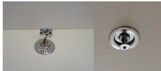
หัวฉีดน้ำอัตโนมัติ (Automatic Fire Sprinkle)
